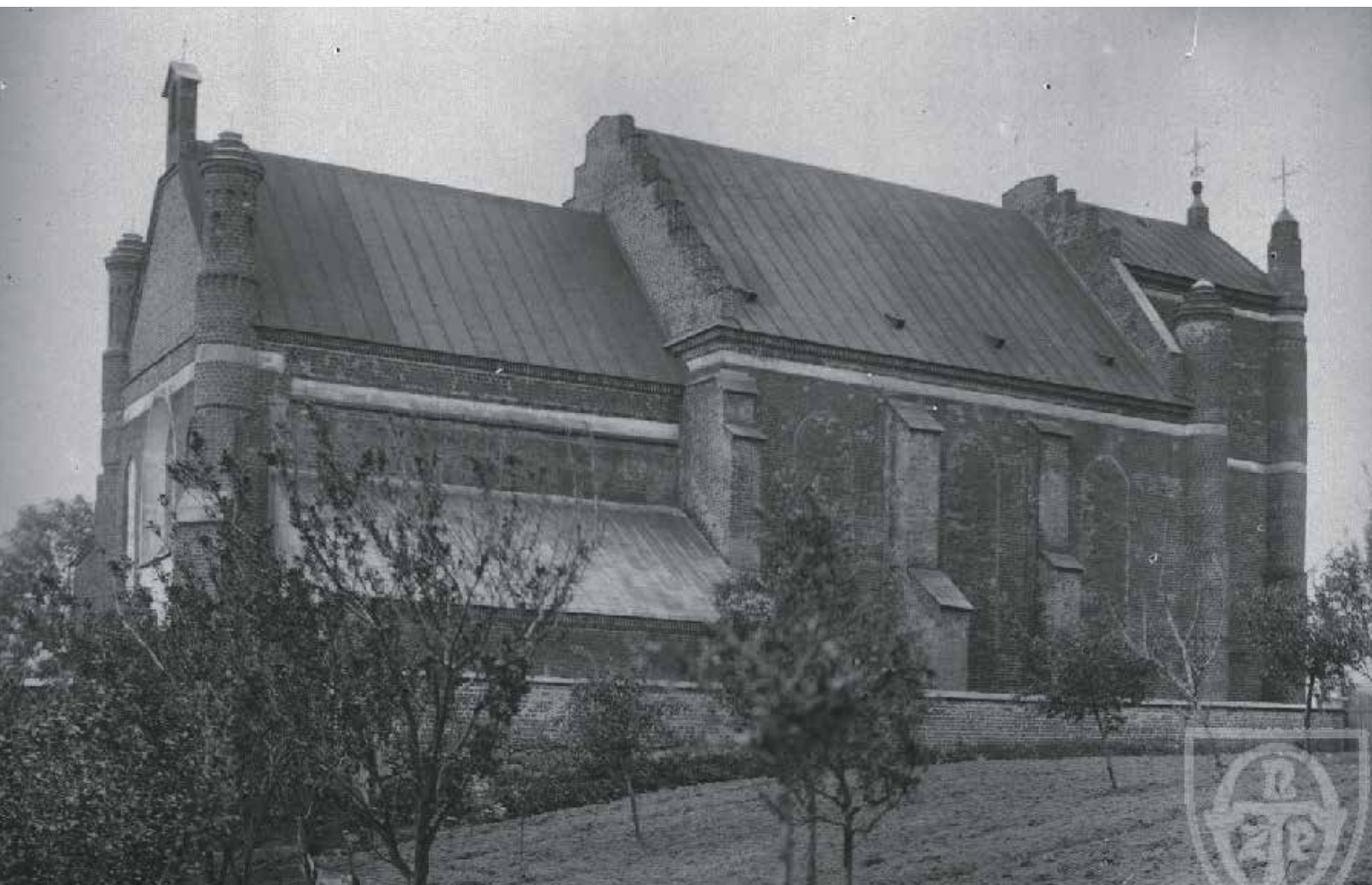
Widok na kościół od północy, fot. Kazimierz Skórewicz, 1913. Dobrze widoczne zamurowane okna jeszcze pod koniec XVIII w. (IS PAN)
