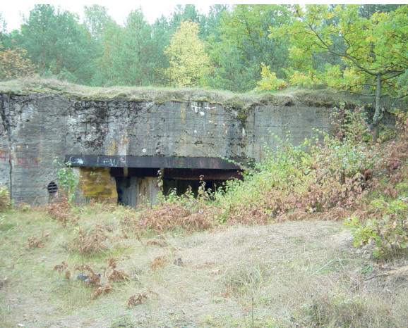
Widok schronu od strony przedpola, 2005 r. (fot. D. Wróbel)
