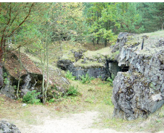
Zniszczona tylna część schronu, 2005 r. (fot. D. Wróbel)
