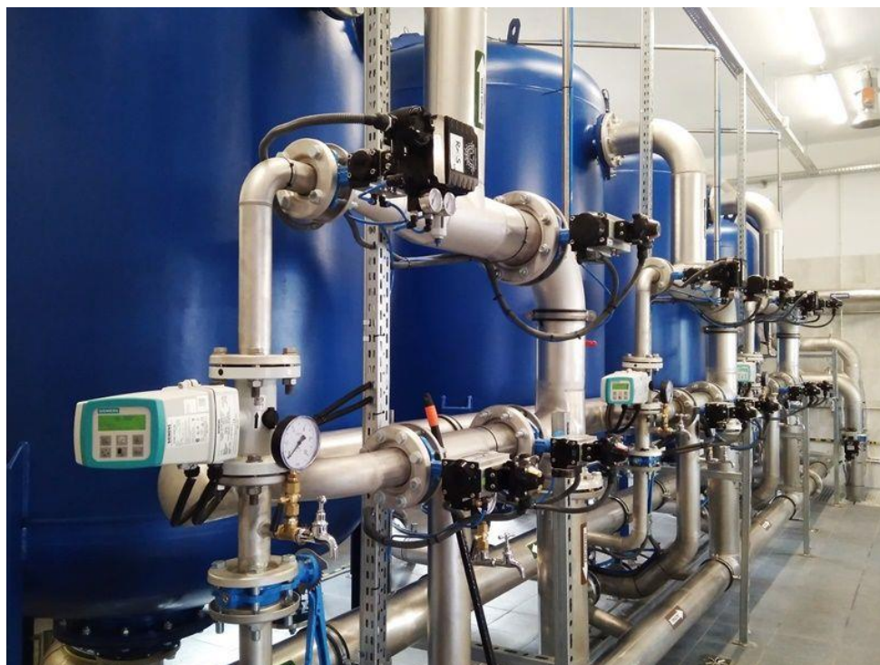
Fot 1. Stacja Uzdatniania Wody w Serocku
