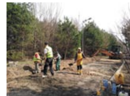
Przebudowa nawierzchni drogi ul. Cz. Miłosza w Serocku
