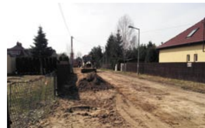
Budowa kanalizacji sanitarnej w ul. Okrężnej i Dojazdowej w Jadwisinie
