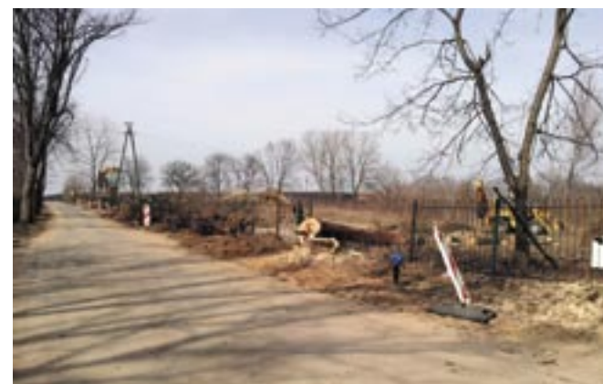
Budowa chodnika w pasie drogi gminnej w Wierzbicy
