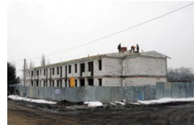
Budowa budynku socjalnego
