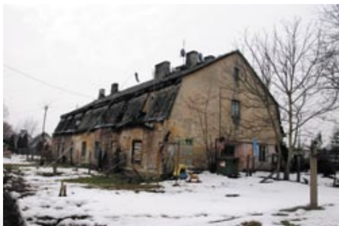
Budynek mieszkalny dawnego folwarku od wschodu
