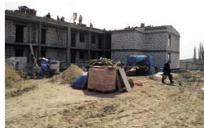
Budowa budynku wielorodzinnego w Jadwisinie
